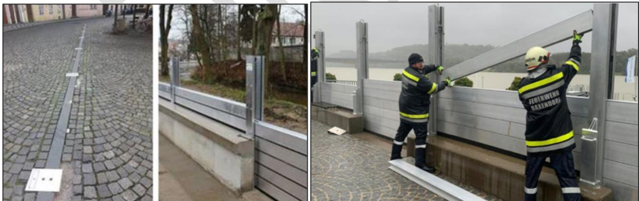
Figur 2.3 Øverst venstre: Bundplade og fundamenter til opsætning af skots med stolper og planker. Øverst højre: Betonmur, der er forhøjet med planker. Nederst: Opsætning af skots med planker ved Donau. Kilder: Kurier.at.
