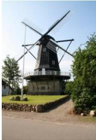
Kettinge Mühle ist ein sogenannter Gallerieholländer weil die Mühle Rundgang einer Galerie genannt wird. Die Untermühle ist ein quadratischer Grundmauer aus gebrannten Ziegeln gebaut, während der Mühlekörper achteckig ist, gebaut aus Holz und mit Eichen – Spännen bedeckt.
