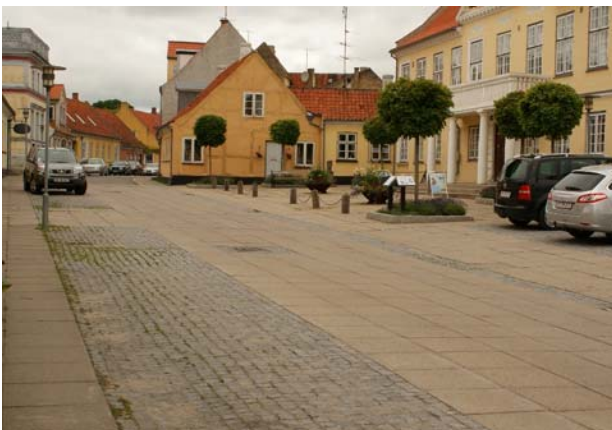
Adelgade foran Rådhuset er forbillede for hvordan belægningen er som en flade gående fra facade til facade.
