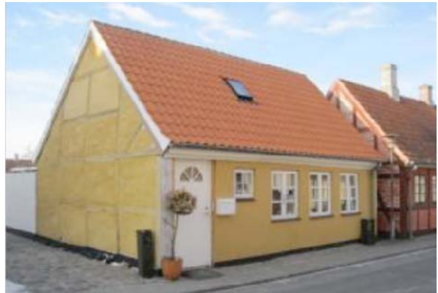
Hus der har fået taget lagt om ved efterisolering. Taget virker nu som en kalot der er sat ovenpå huset
