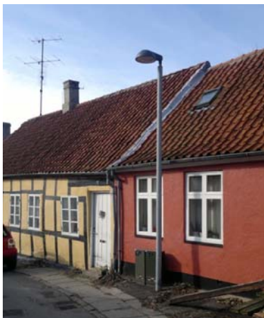
Ny gadelampe der er alt for høj i forhold til skalaen på husene.
