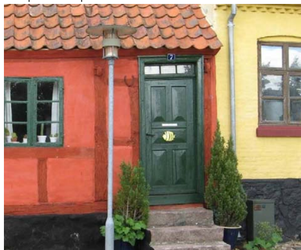
Oprindeligt var hoveddørene mørkere end facaden. Dette videreføres med lokalplanen.
